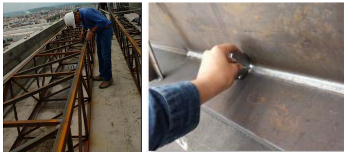
Figura 15. Inspección visual. Fuente, autor
