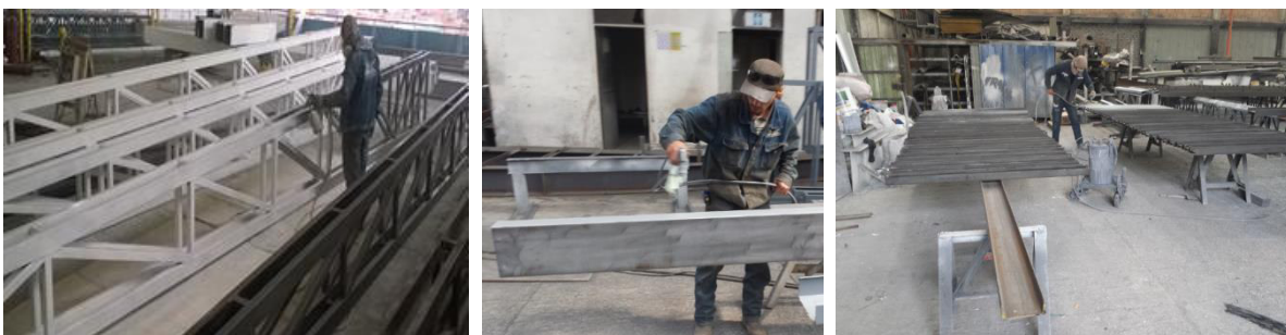
Figura 17. Aplicación de recubrimiento a la estructura metálica. Fuente, autor
