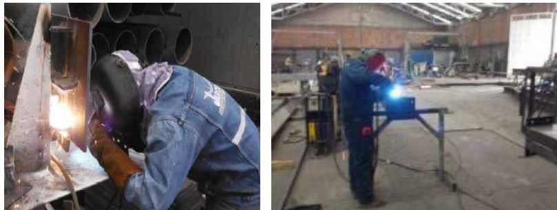
Figura 12. Soldadura de piezas. Fuente, autor
