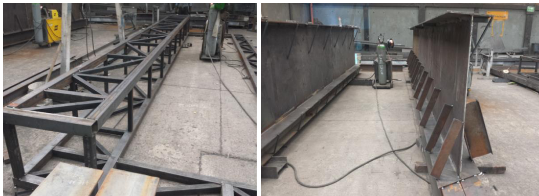
Figura 10. Estructuras pre armadas. Fuente, autor
