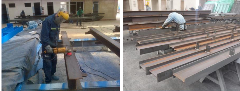
Figura 14. Limpieza con herramienta mecánica. Fuente, autor
