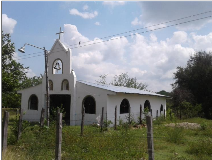
Fotografía 1 Vista de la Iglesia. Fuente (PetroBlast SAS, 2017)
