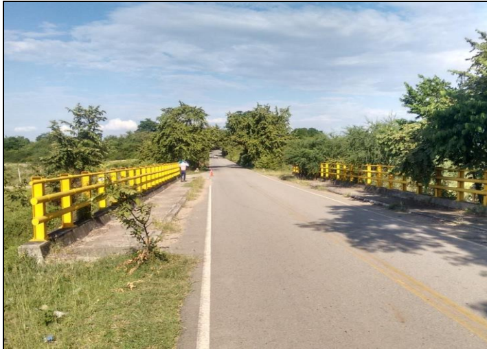
Fotografía 6 Vista del Puente. Fuente (PetroBlast SAS, 2017)
