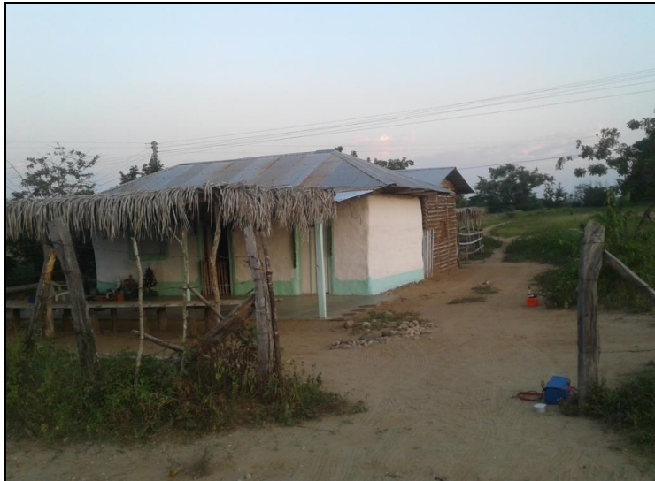
Fotografía 4 Vista de la casa. Fuente (PetroBlast SAS, 2017)
