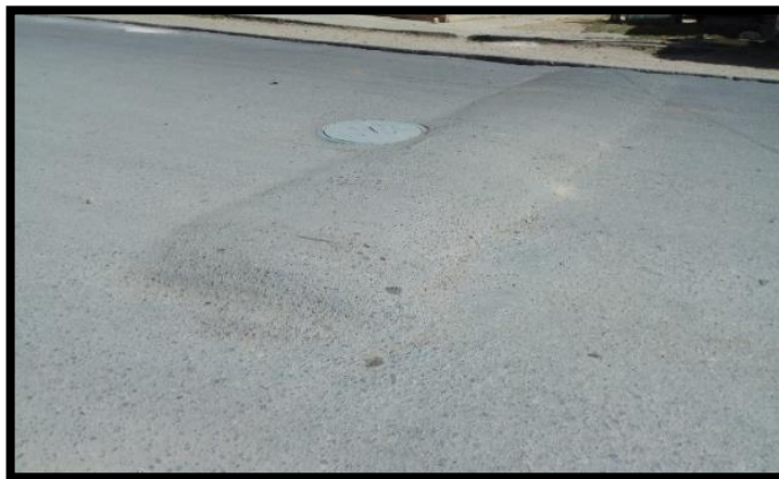
Figura 23. Señal Horizontal (Resalto) en buen estado, no visible
