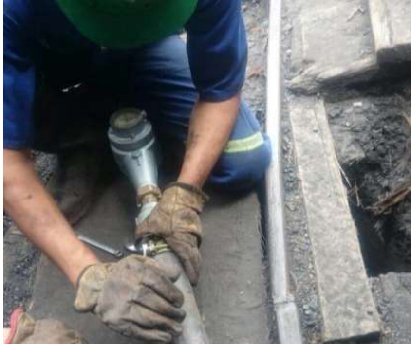
Figura 16. Instalación del equipo de medición
