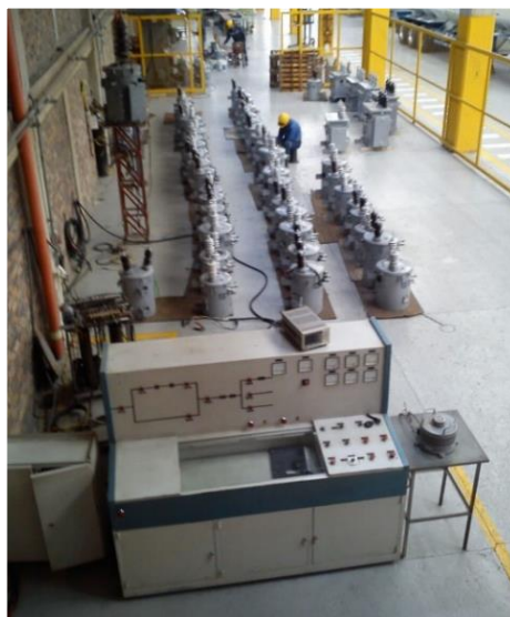
Figura 16. Campo de Pruebas de Construcciones y Montajes Electroductama
