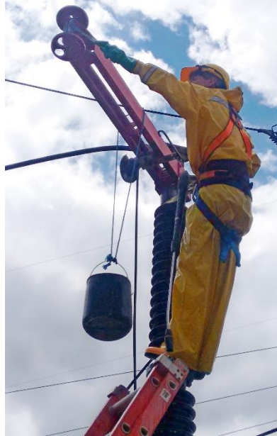
Figura 55. Engrase de contactos de un seccionador. Subestación Termopaipa
