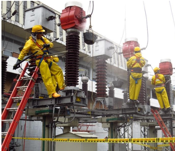
Figura 22. Limpieza a transformador de corriente, subestación Termopaipa
