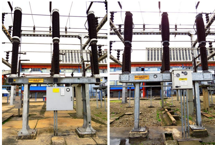
Figura 40. Interruptor de potencia para 115 kV con medio de extinción SF6 y mecanismo de resorte tripolar.
