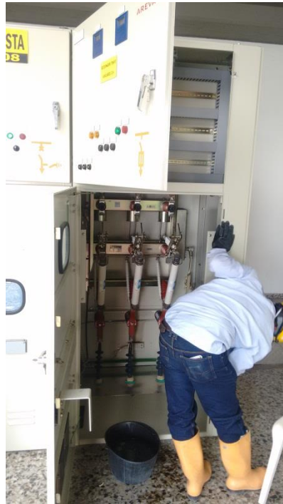
Figura 64. Mantenimiento al seccionador de auxiliares. Subestación Higueras.
