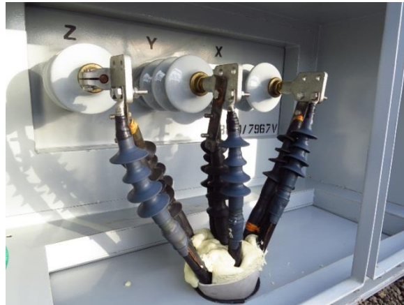
Figura 26. Sellamiento con espuma industrial de poliuretano. Entrada de cables XLPE al transformador. Subestación San Antonio
