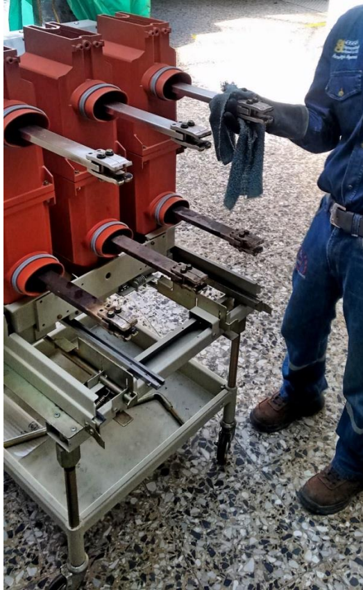
Figura 59. Limpieza a un interruptor de 13,8 kV. Subestación Higueras
