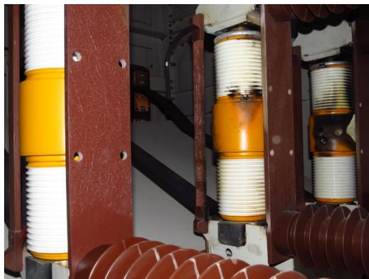
Figura 71. Explosión en botellas de vacío.
