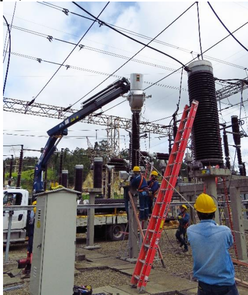
Figura 14. Cambio de 3 transformadores de corriente CT, subestación Termopaipa, anillo 220 kV.
