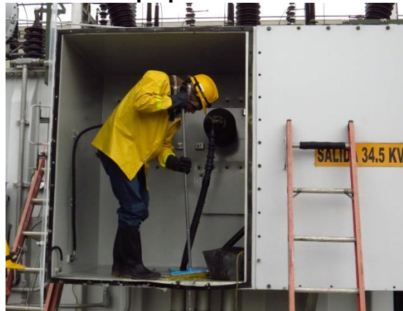
Figura 32. Limpieza al gabinete de 34,5 kV de un transformador tridevanado. Subestación Termopaipa
