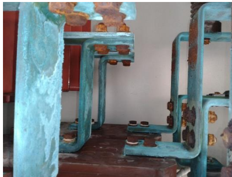
Figura 68. Contactos sulfatados
