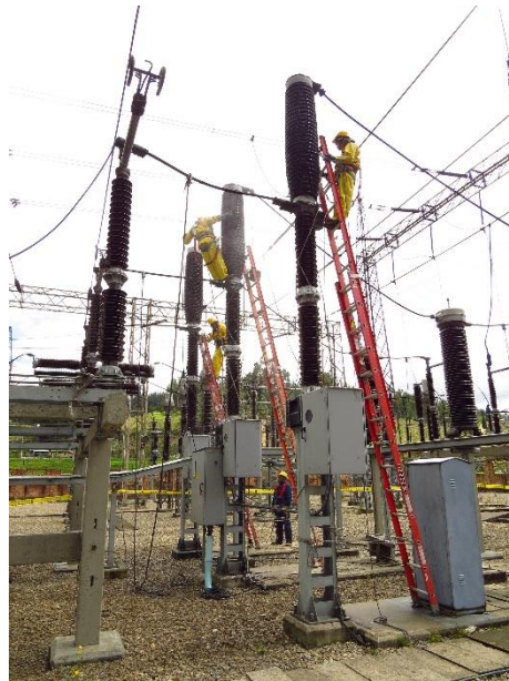
Figura 27. Mantenimiento realizado a un interruptor de 220 kV. Subestación Termopaipa.
