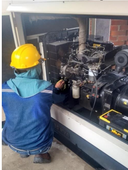
Figura 63. Mantenimiento a la planta de emergencia
