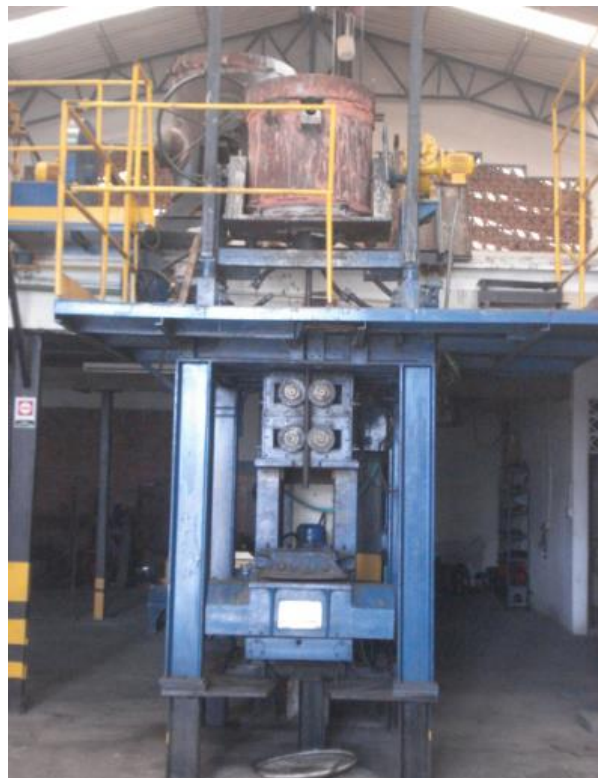
Figura 31. Máquina de colada continua de la empresa.
