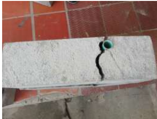
Ilustración 45. Viga con tubo de 1" pos-falla
