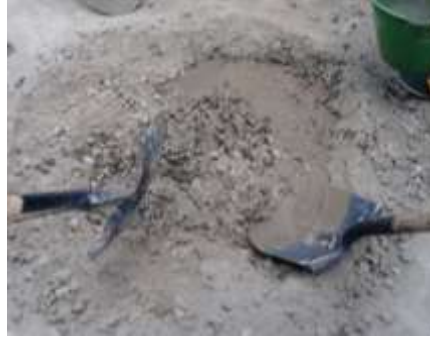
Ilustración 26. Adición de agua durante el proceso de mezclado
