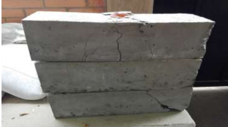
Ilustración 40. Patrón de agrietamiento de vigas reforzadas.
