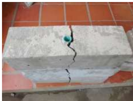
Ilustración 41. Vigas con tubo de 1" pos-falla.
