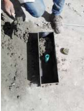
Ilustración 30. Fundición de las vigas.
