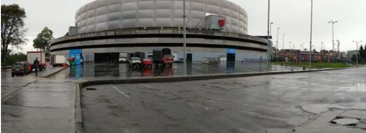
Figura 37. Parqueadero Movistar Arena.
