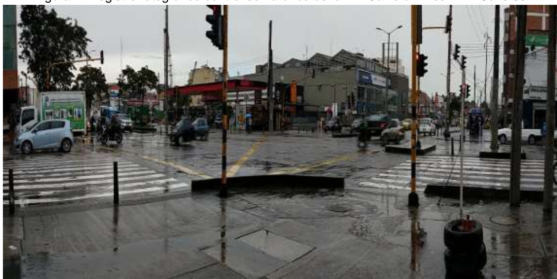
Figura 7. Registro fotográfico control semafórico de la Av. Carrera 24 con Av. Calle 63.
