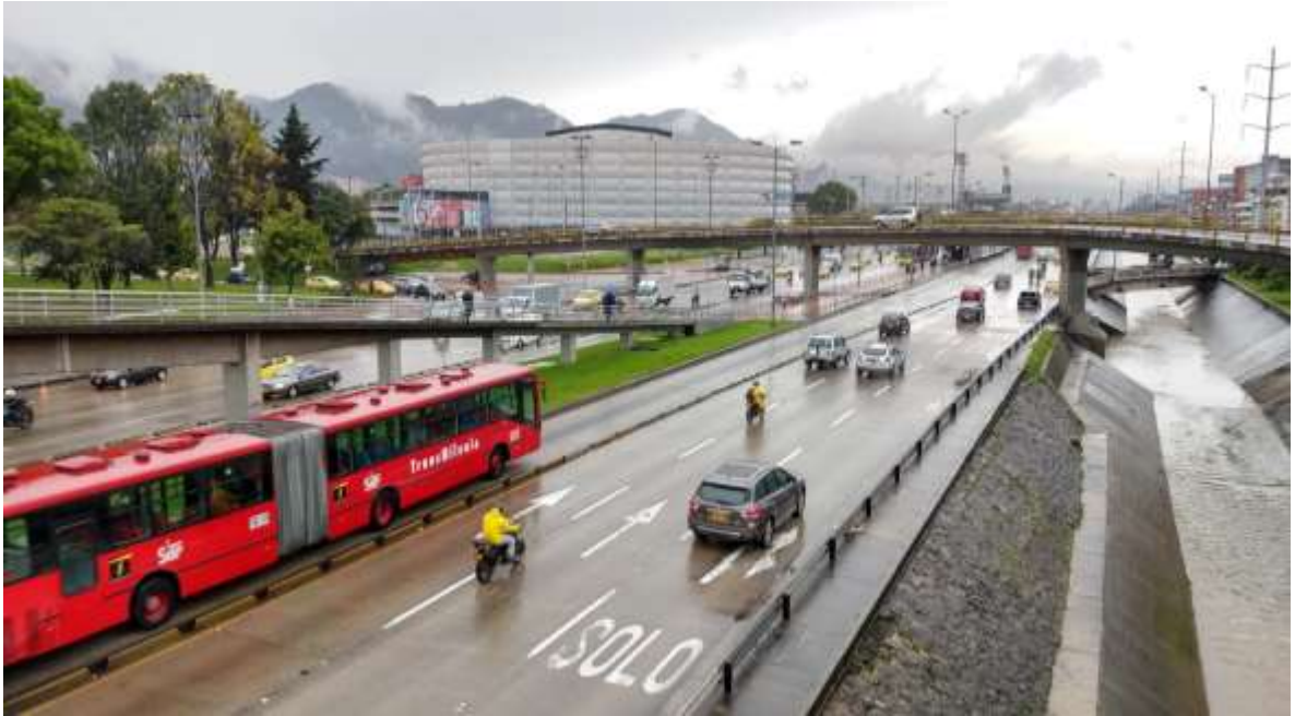
Figura 5. Registro Fotográfico de Reconocimiento.
