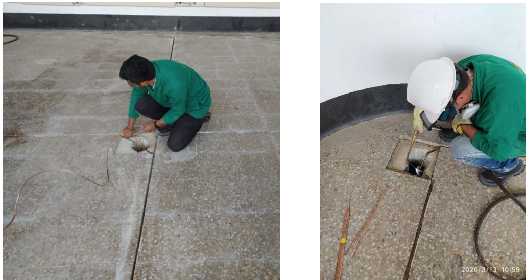
Figura 12. Instalación de sistema puesta a tierra
