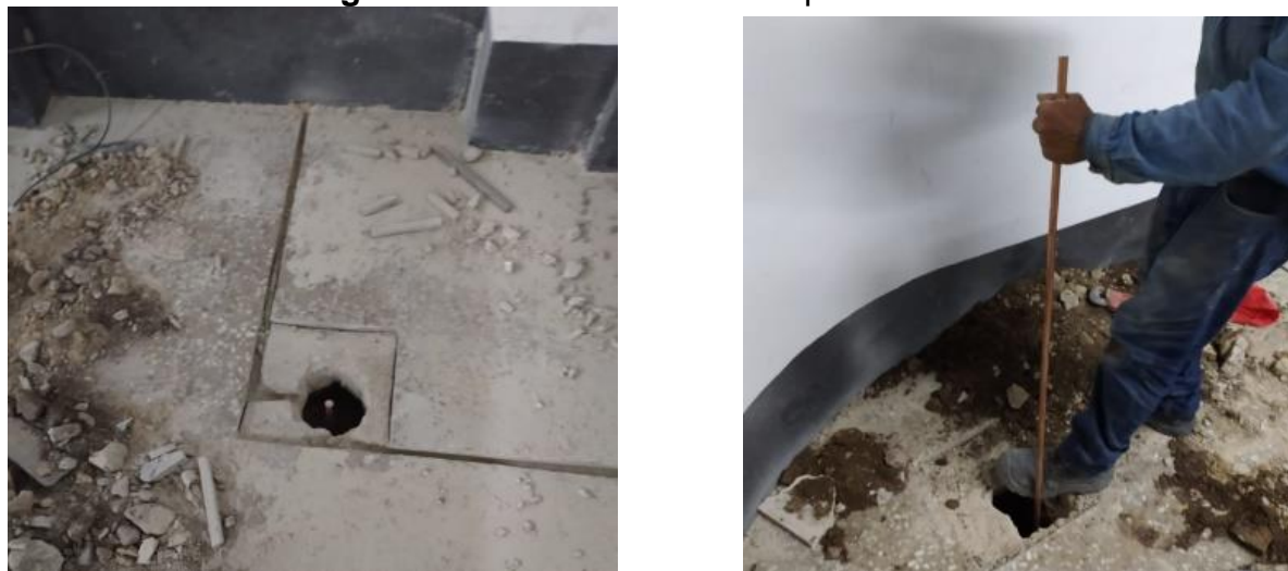
Figura 10. Adecuación sistema puesta tierra
