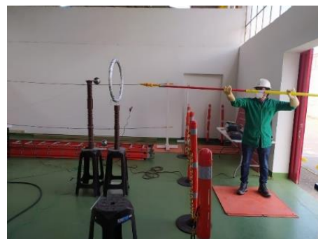
Ensayo de operación de cortacircuitos mediante fuente de corriente de 1200 A
