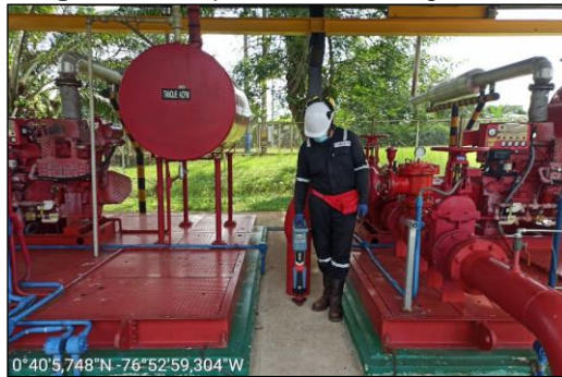
Figura 13. Inspección PCM segmento 7
