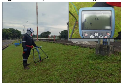
Figura 46. Inspección ACVG segmento 51
