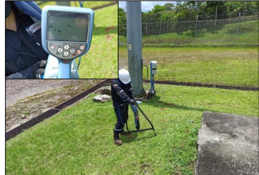
Figura 60. Inspección ACGV segmento 65
