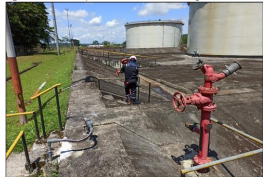
Figura 44. Inspección ACGV segmento 48-3
