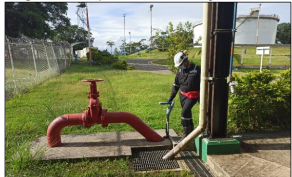
Figura 20. Inspección ACVG segmento 14-2
