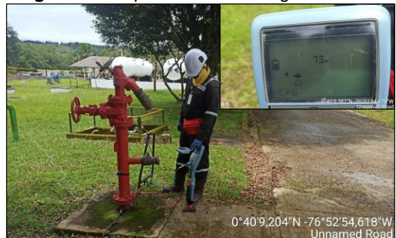
Figura 56. Inspección ACGV segmento 56-2
