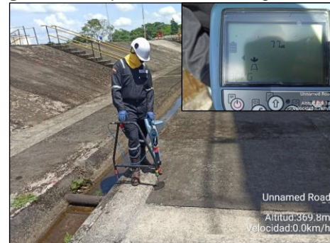
Figura 26. Inspección ACVG segmento 23
