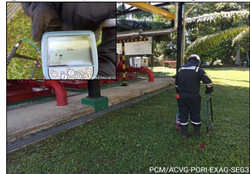
Figura 12. Inspección ACVG segmento 3-2
