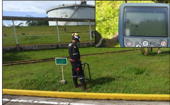
Figura 18. Inspección ACGV segmento 14-1
