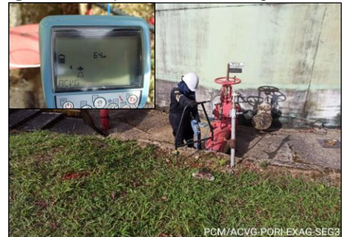
Figura 10. Inspección ACVG segmento 3-1
