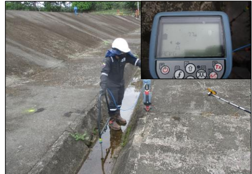
Figura 28. Inspección ACGV segmento 26
