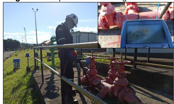
Figura 64. Inspección ACGV segmento 67-2
