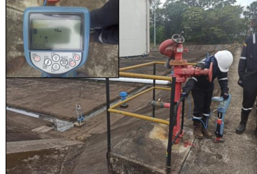
Figura 52. Inspección ACGV segmento 53-3
