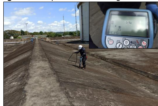
Figura 40. Inspección ACGV segmento 48-1
