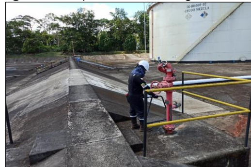
Figura 42. Inspección ACVG segmento 48-2
