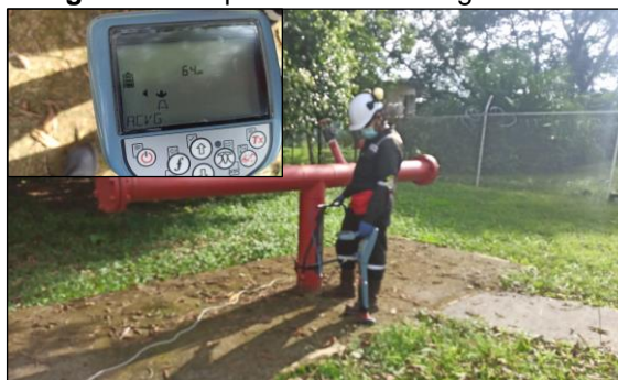
Figura 22. Inspección ACVG segmento 16
