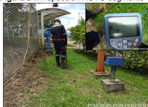
Figura 24. Inspección ACVG segmento 19
