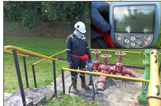
Figura 48. Inspección ACGV segmento 53-1
