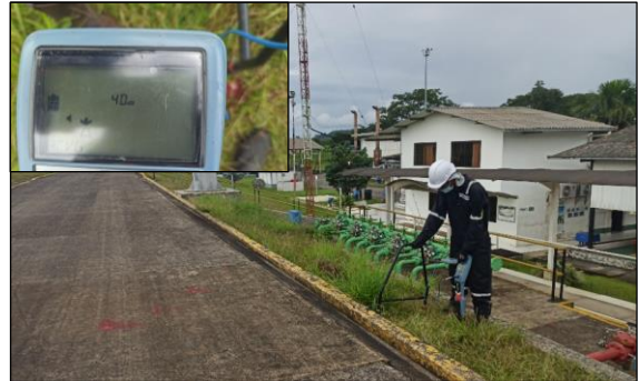
Figura 38. Inspección ACVG segmento 46
