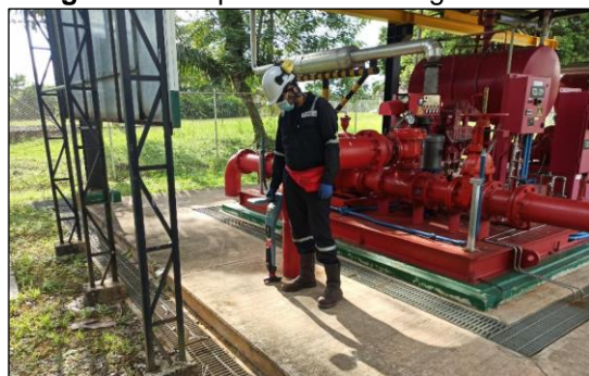
Figura 15. Inspección PCM segmento 11
