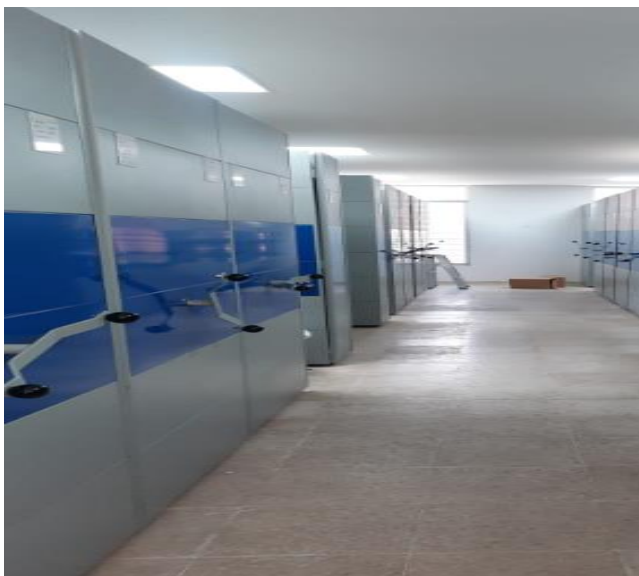
Ilustración 10 Estantería Rodante Depósito.
