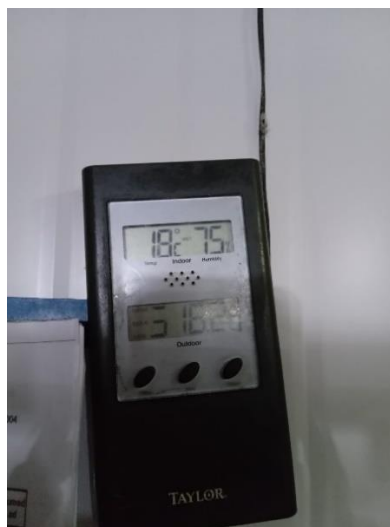
Imagen 5. Tablero medidor de temperatura y humedad cuarto frío
