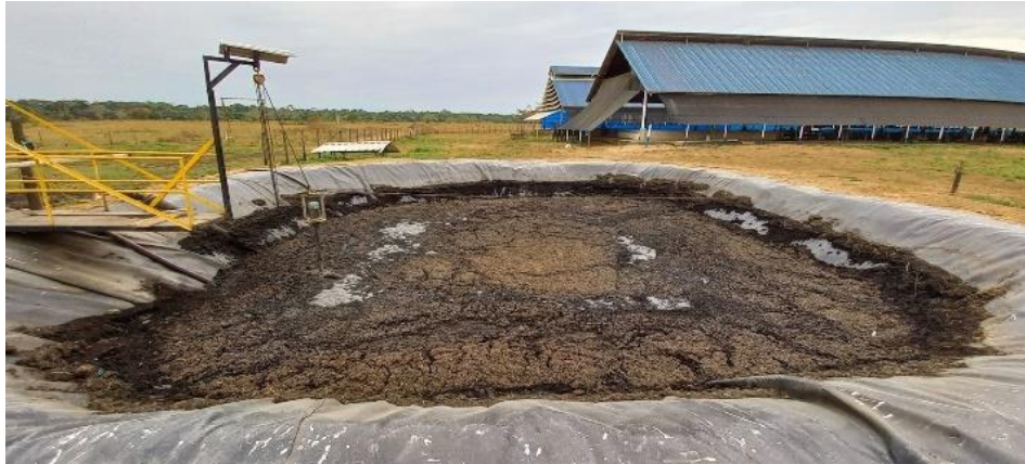
Ilustración 29.- Pozo estercolero. (autor, 2021)
