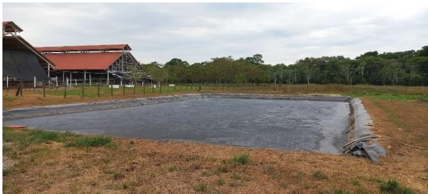
Ilustración 31.- Piscina de oxidación. (autor, 2021)
