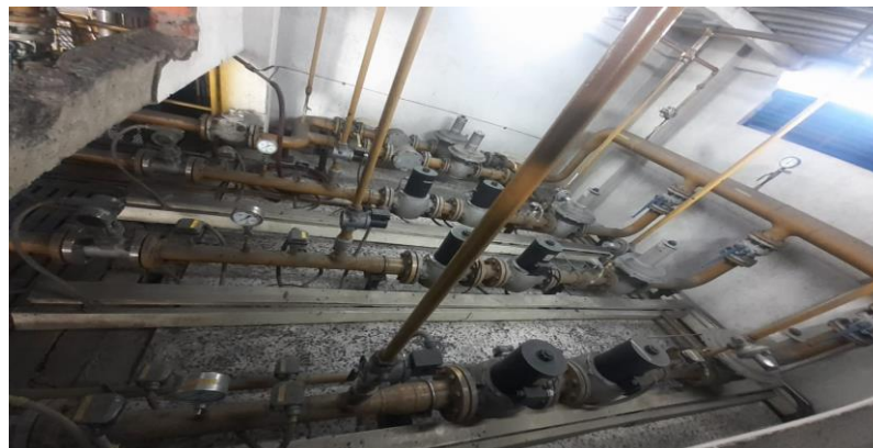
Figura 3 Circuito Gas Natural de Combustión
