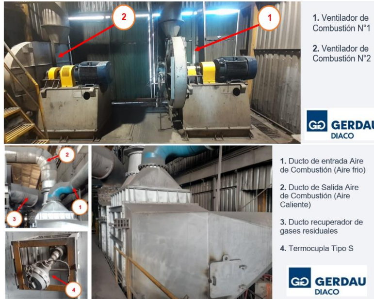
Figura 2 Circuito Aire de Combustión
