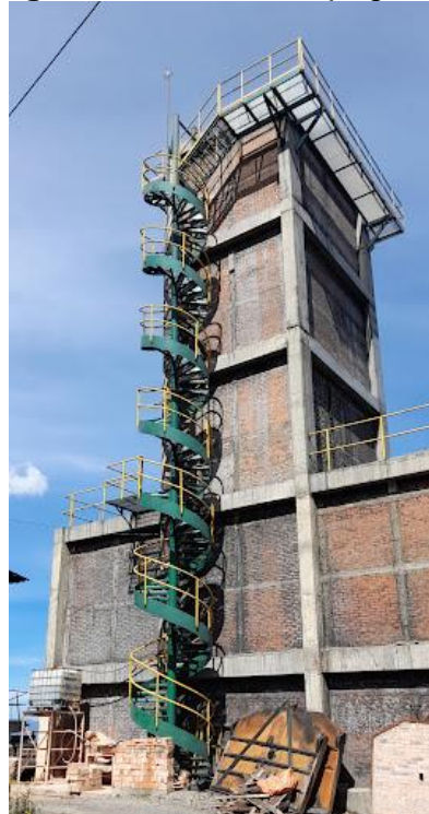
Figura 14. Torre de apagado.
