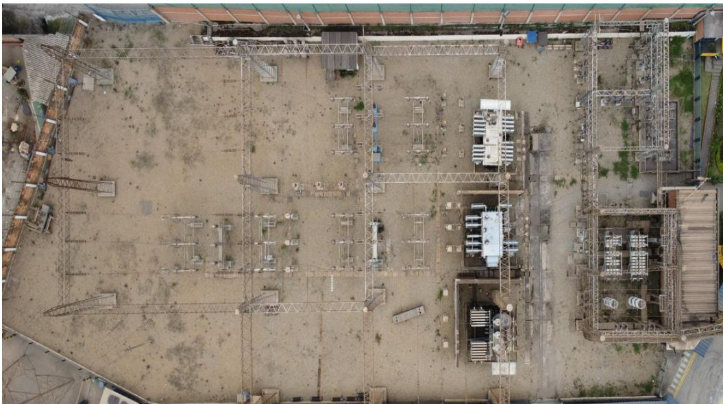
Ilustración 2 Subestación Eléctrica 115kV/13,2-13,8kV
