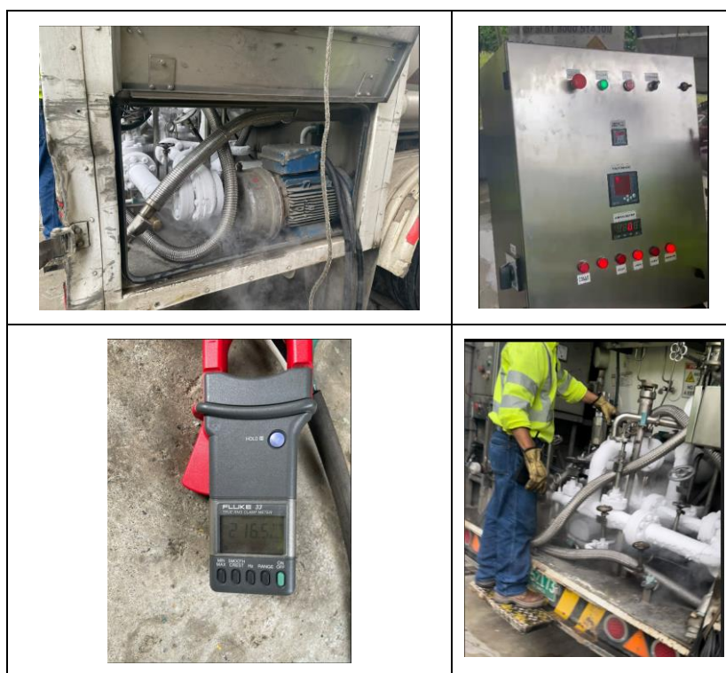
Figura 29. Prueba con carga
