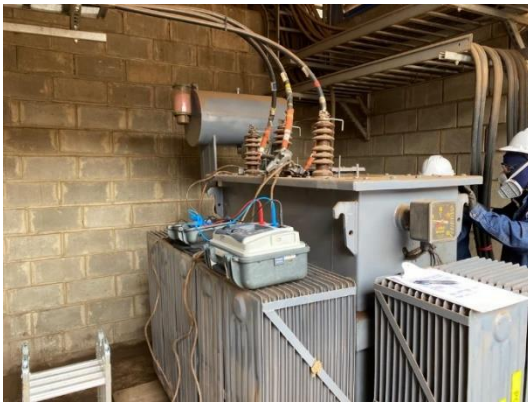
Ilustración 33. Trabajos externos con la empresa ELÉCTRICOS GONZÁLEZ- Empresas regionales transformador de 1250 KVA
