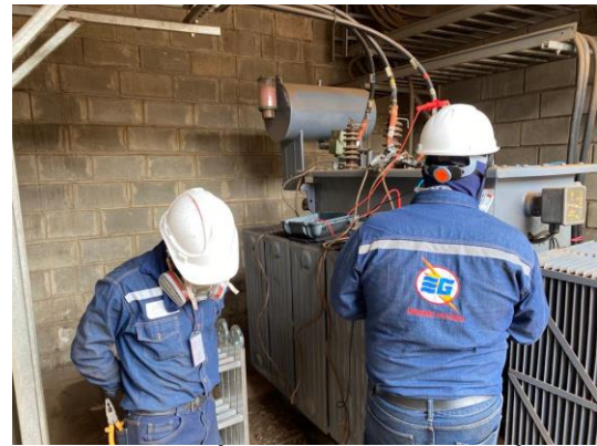
Ilustración 33. Trabajos externos con la empresa ELÉCTRICOS GONZÁLEZ- Empresas regionales transformador de 1250 KVA
