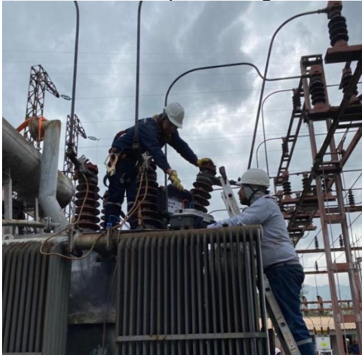
Ilustración 34. Trabajos externos con la empresa ELÉCTRICOS GONZÁLEZ- Empresas regionales transformador de 3000 KVA
