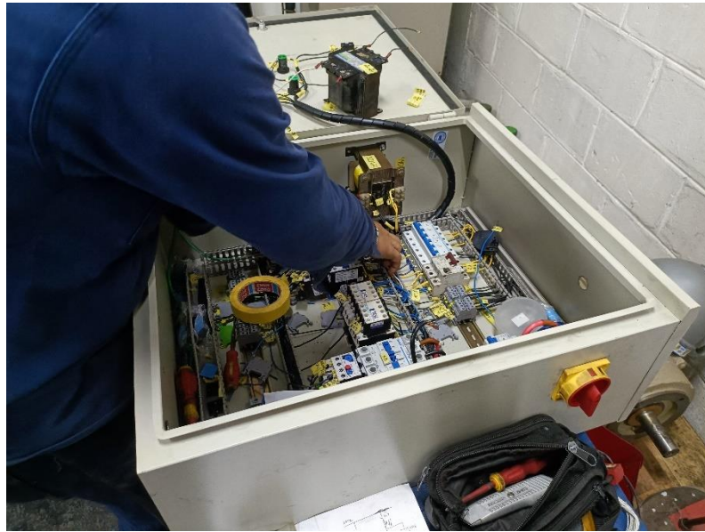
Elaboración de tablero de potencia.
