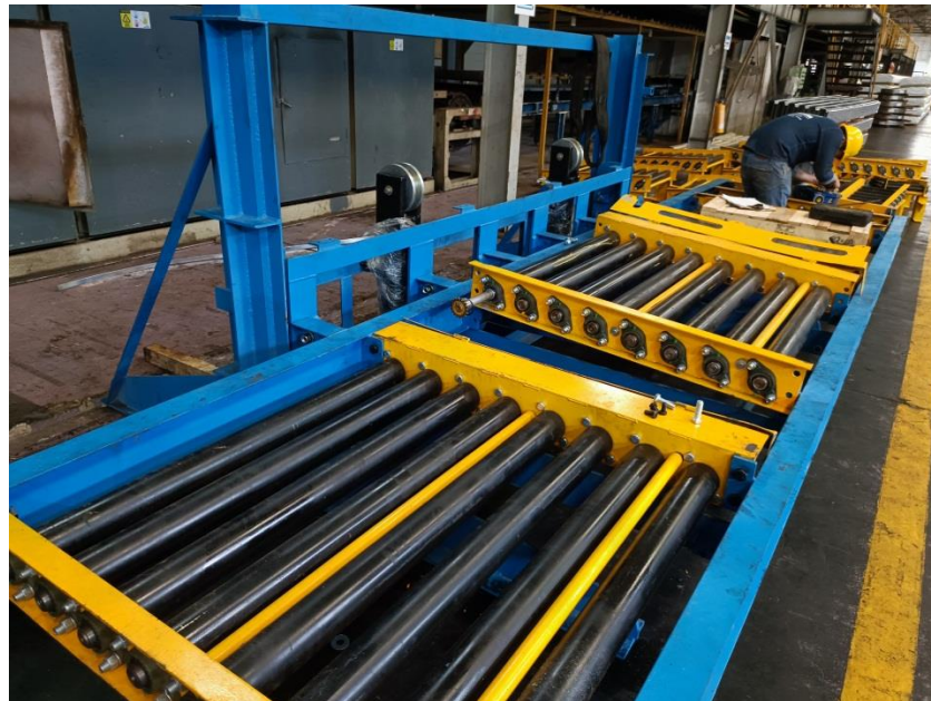
Instalación de motor reductor.
