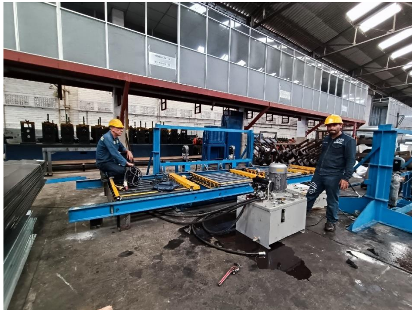
Finalización de ensayos.
