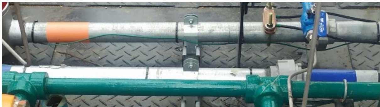
Figura 78. Señalización de ruteo eléctrico
