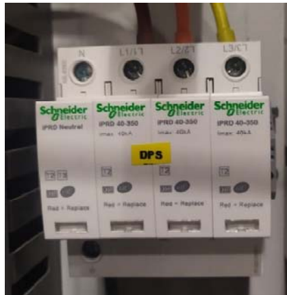
Figura 54. DPS TIPO 2 de Schneider Electric
