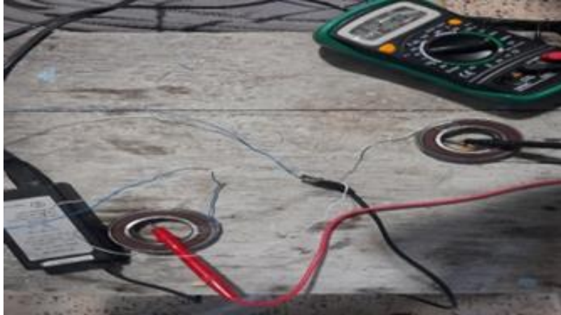
Figura 23. Prueba de voltaje conector rotativo.
